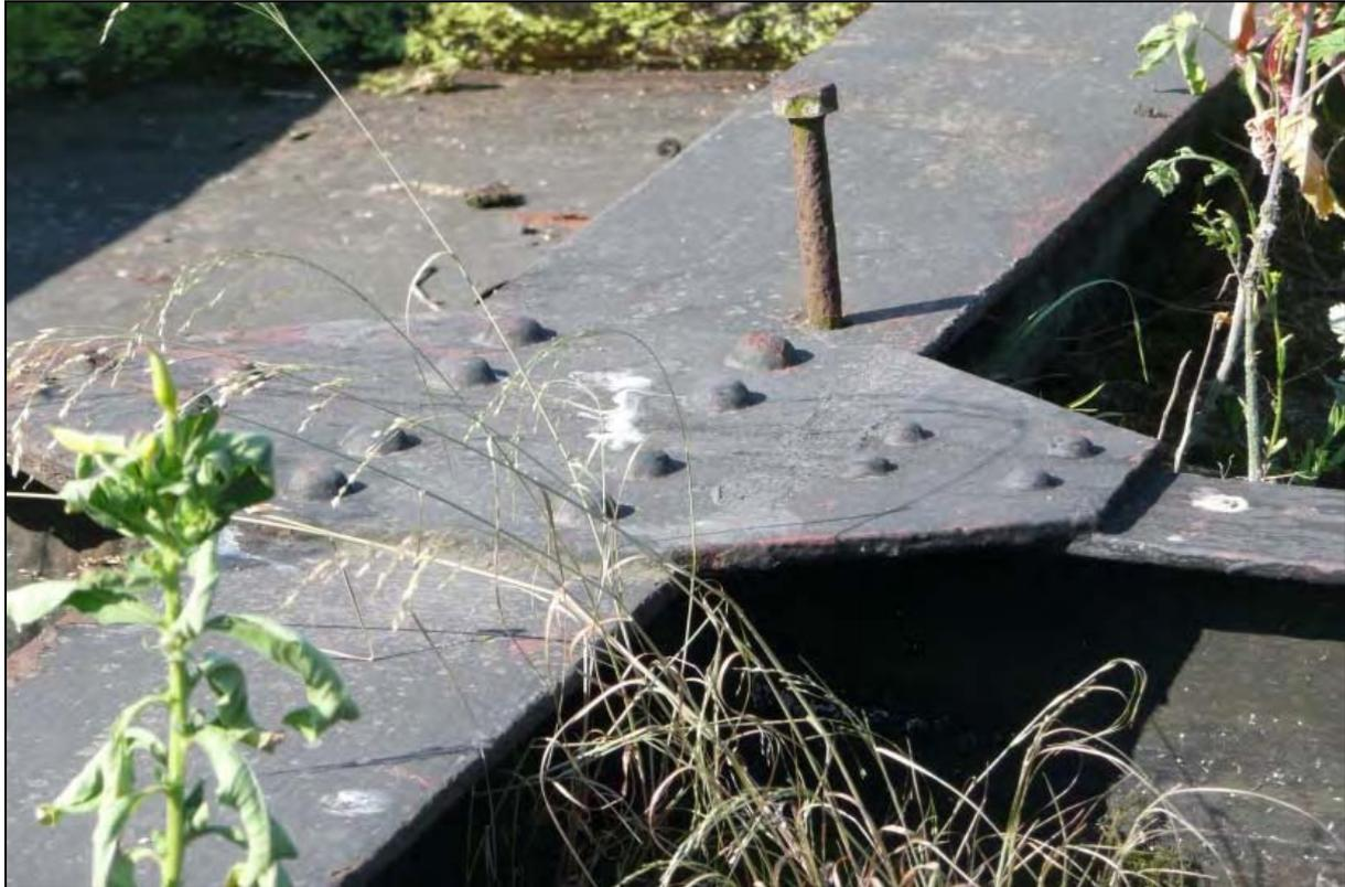
Abbildung 10: Teil eines Schleusentors mit asbest- und PAK-haltigen Anstrichen
