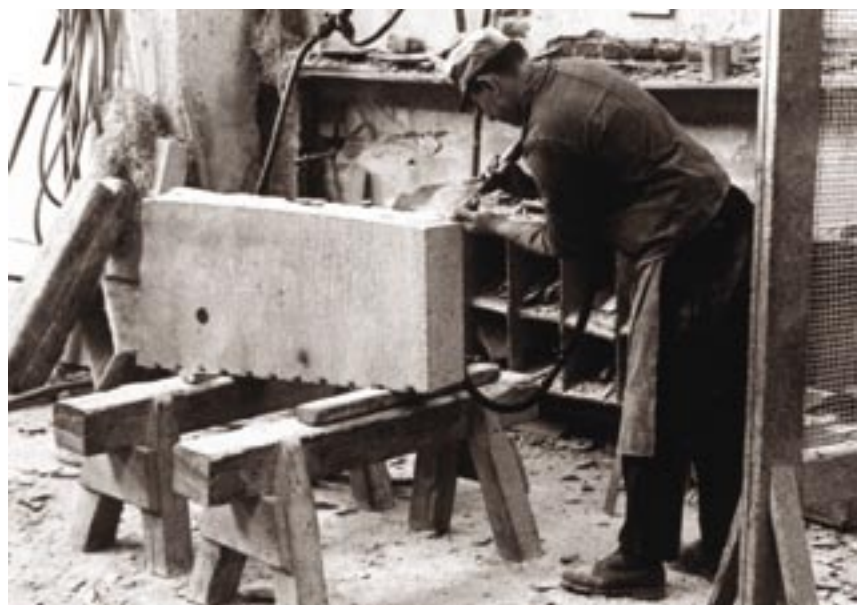
Abbildung 7: Steinmetzarbeiten in den 1960er-Jahren.
