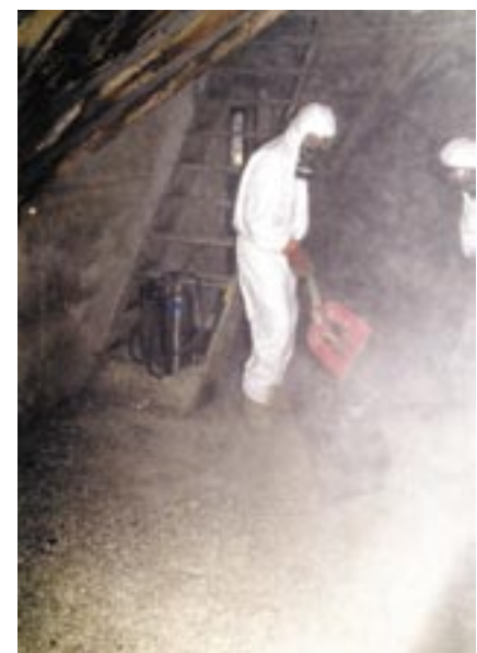
Abbildung 7: Starke Staubentwicklung beim Entfernen von Taubenkot auf einem Dachboden (Foto: Andreas Albrecht).
