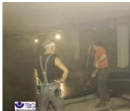
Abbildung 8: Verarbeitung von Gussasphalt.
