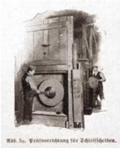
Abbildung 22: Schleifscheibenprüfstände einst (Deutscher Schleifscheibenausschuss – DSA) 1934 und heute (BGIA).
