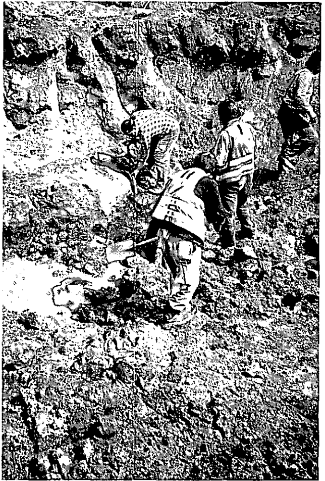
Abbildung 23: Schaufelarbeit nach Rohrbruch (C1 38)
