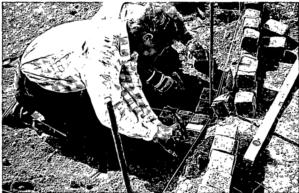
Abbildung 21: Regenwassermulde auspflastern (CI 35)
