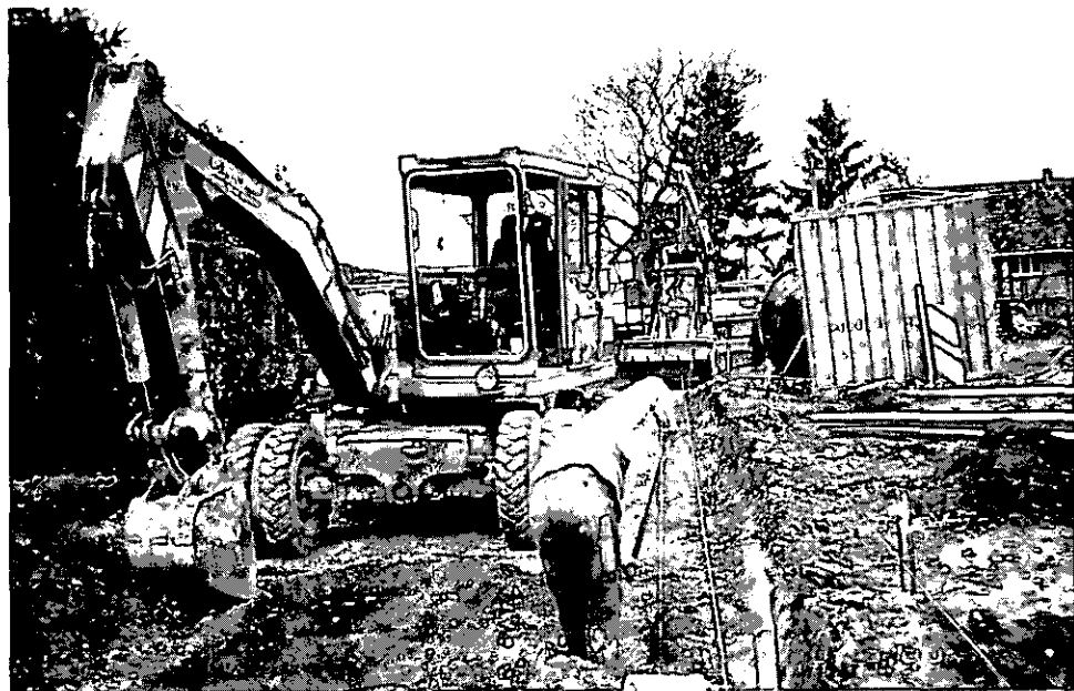
Abbildung 17: Bagger einweisen und nachschachten (C1 28)
