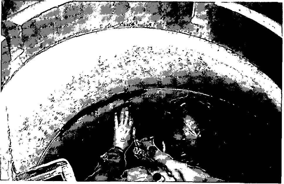
Abbildung 18: Kanalschacht ausfugen (C1 30)
