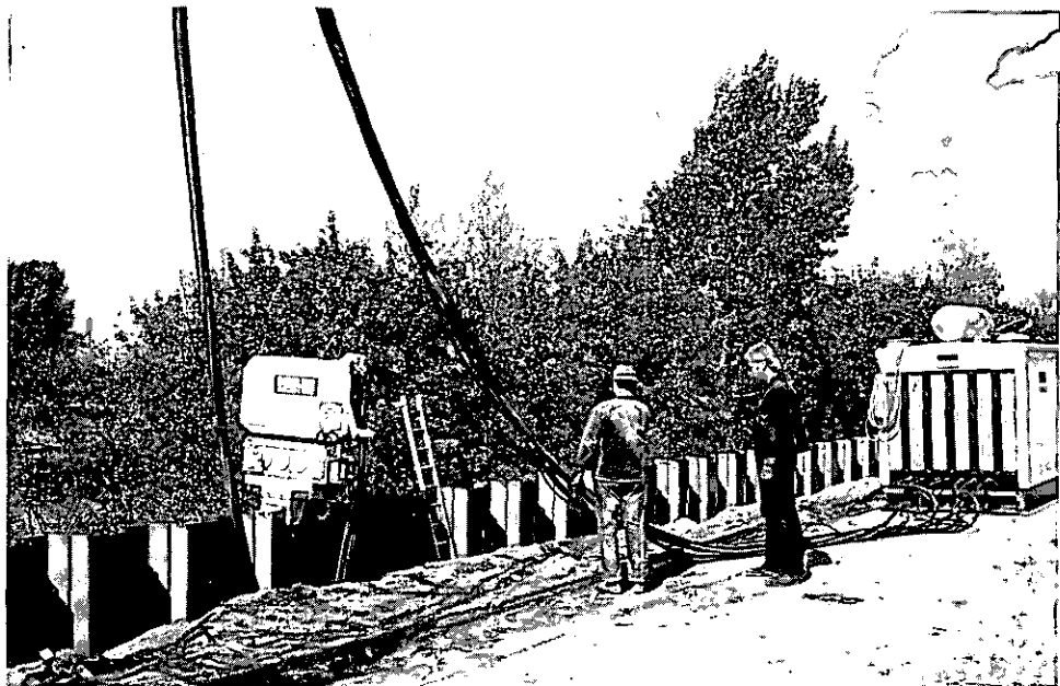
Abbildung 16: Vorbereitung des Spundbohlenziehens mit Vibrationsramme (C1 23)
