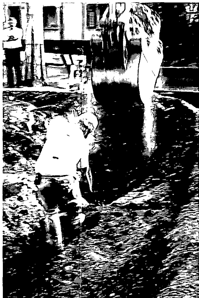
Abbildung 8: Nachschachten in Baggernähe (C1 11)
