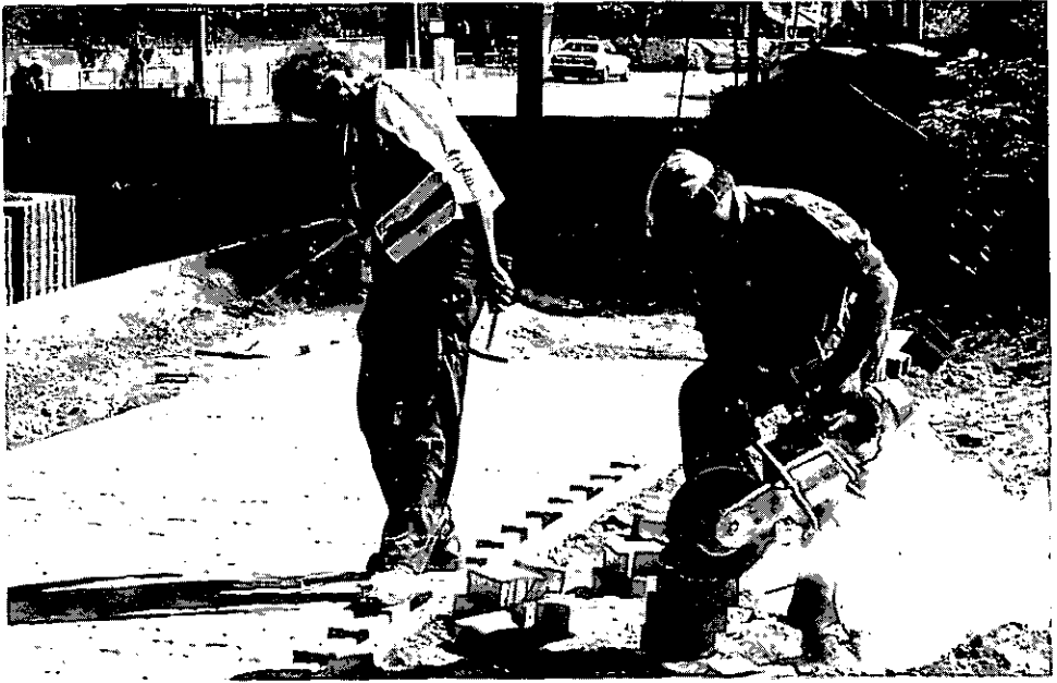
Abbildung 26: Gehwegverbundpflaster schneiden (C1 44)
