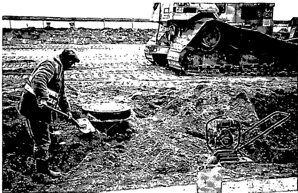
Abbildung 19: Planum um Kanalschacht verdichten (CI 33)
