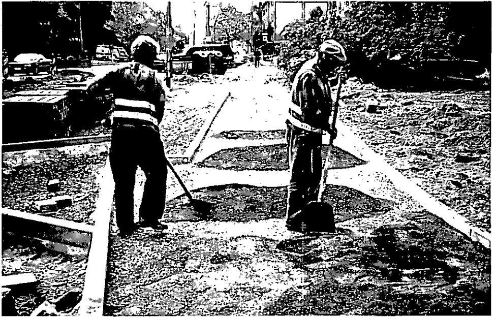
Abbildung 25: Gehwegplanum erstellen (C1 42)
