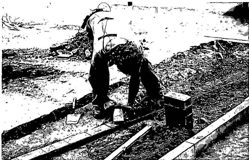
Abbildung 12: Randsteine setzen (CI 17)
