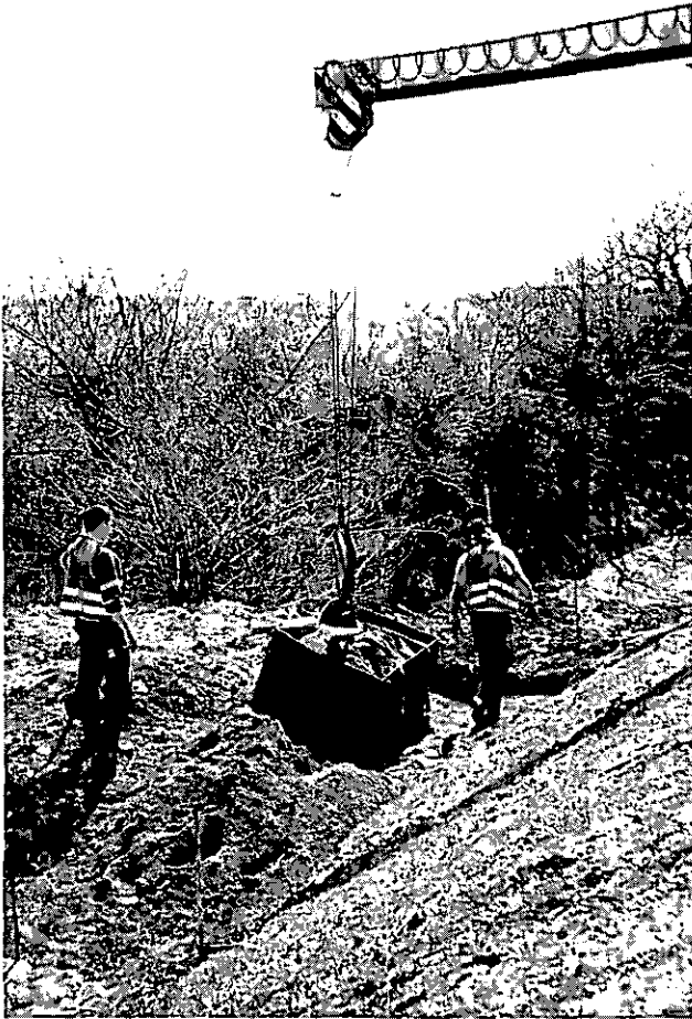
Abbildung 20: Transportbeton annehmen (C1 34)
