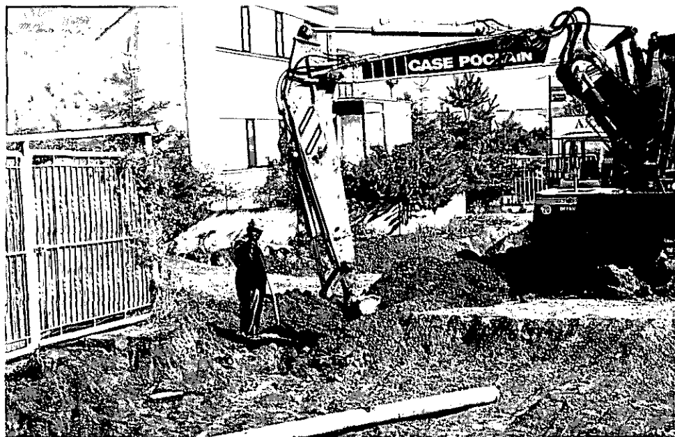
Abbildung 14: Bagger einweisen und nachschachten (C1 21)
