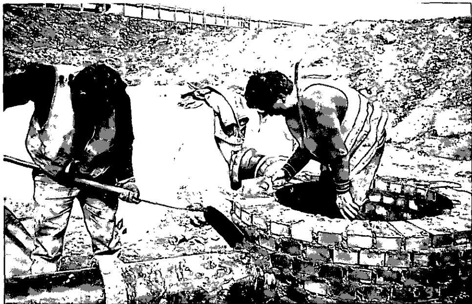
Abbildung 22: Revisionschacht mauern (C1 36)
