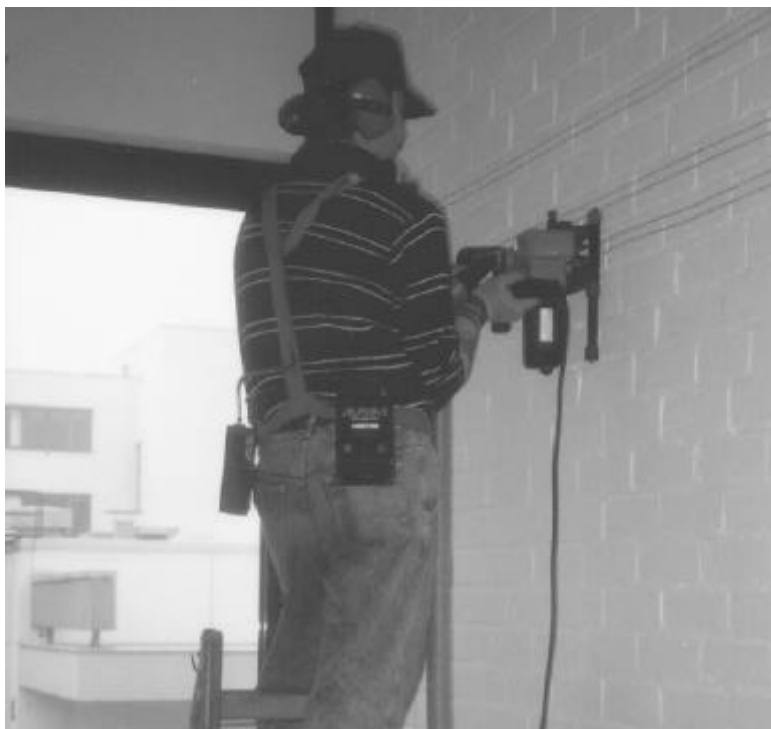
Abbildung Schlitzen einer Kalksand- steinwand mit einer Mauernutfräse
