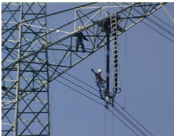
Abbildung Typische Arbeitssituation im Freileitungsbereich
