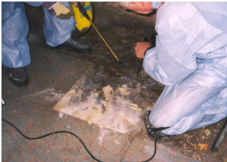
Abbildung Ausbau von Flexplatten
