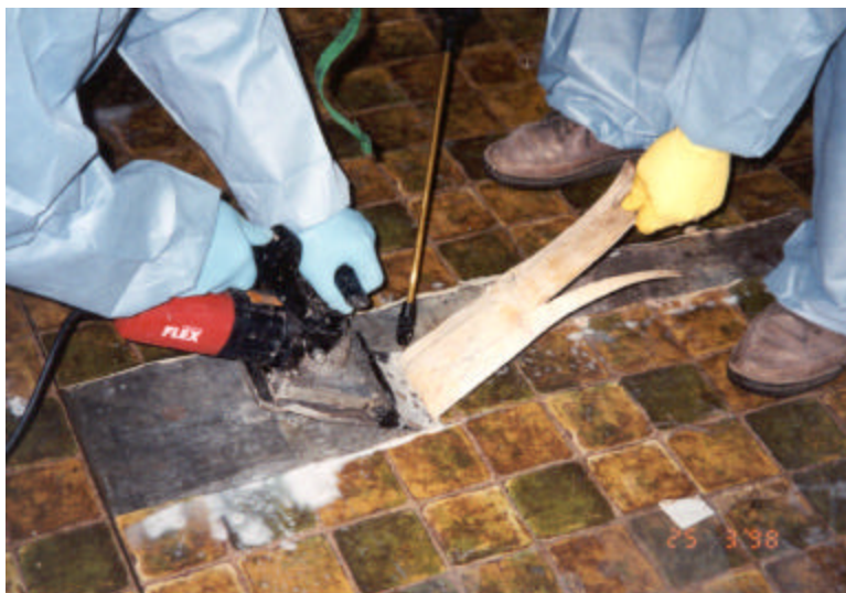
Abbildung Ausbau von CV-Belägen
