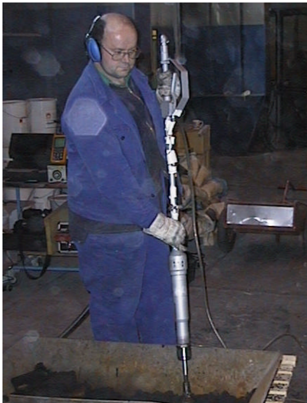
Abbildung: Druckluft-Stampfer beim Verfestigen von Ofenausmauerungen
