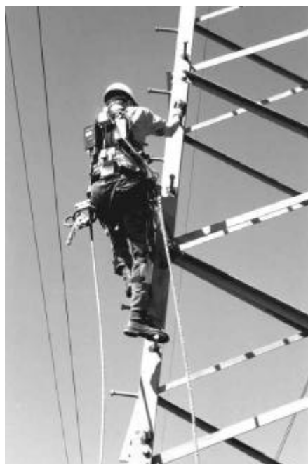
Abbildung 2-22: Einsatz des CUELA-Messsystems im Freileitungsbau
