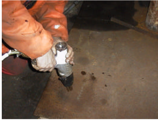
Abbildung 2-18: Arbeiten mit einem Nadelentroster
