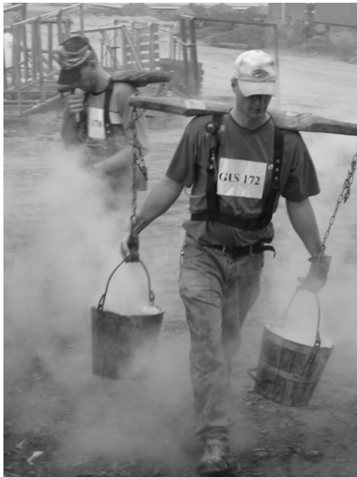
Abbildung 2-15: Arbeiten mit Gussasphalt
