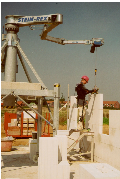
Abbildung Erfassung von Körperhaltung und gehandhabtem Lastgewicht beim Mauerwerksbau mit einem Minikran als Versetzhilfe
